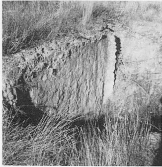
Foto 40. Valdearenas: Pared interior del horno
