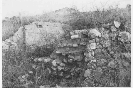
Foto 38. Utande: Restos del horno
